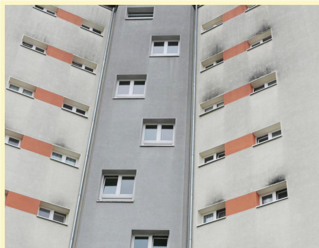
Permanentes Kipplüften: An den Hausfassaden ist das Fehlverhalten deutlich zu sehen. Die grauen Schleier entstehen durch Algen- bzw. Pilzbildung, sehen unschön aus und machen deutlich, wo falsch gelüftet wird.
