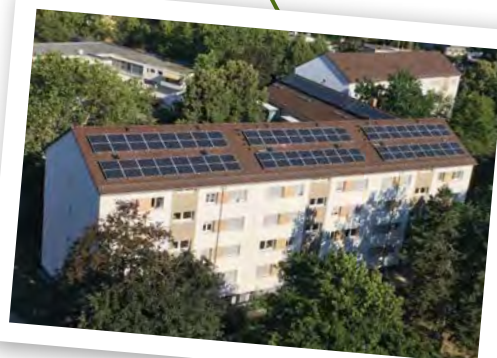
Photovoltaikanlage im Hessenring 15
