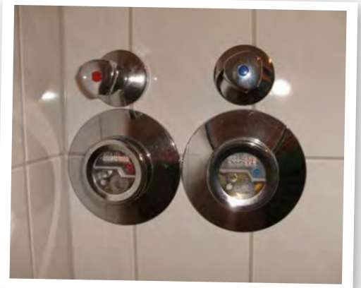
Die frühe Nachrüstung von Wasserzählern war zur damaligen Zeit eine Besonderheit
