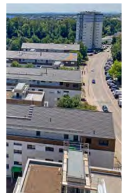
Quartier im Hessenring vorher (oben) und nachher (unten)
