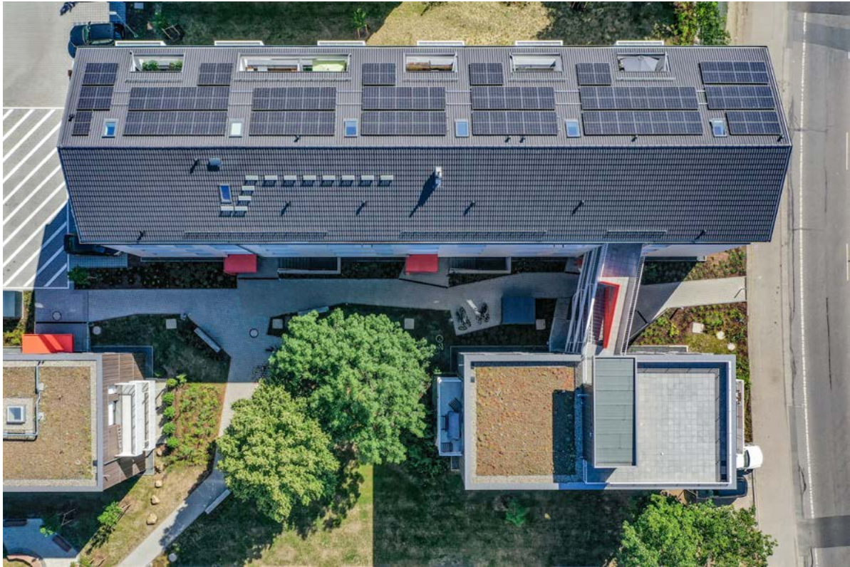
Ein fertig entwickeltes Quartier im Hessenring 16-38
